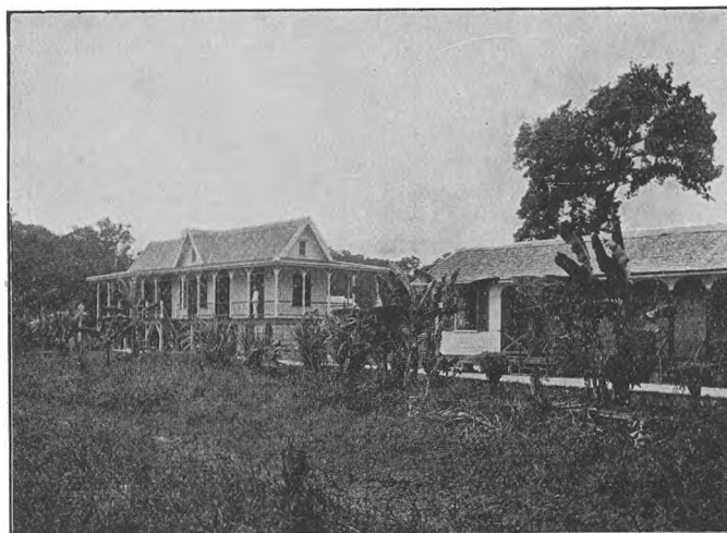
Bethesda : Twee zieken-woningen van de mannenafdeeling.
